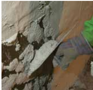
Aufbringen des KÖSTER Sanierputzes
