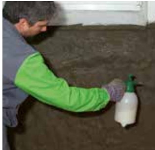
Grundieren mit KÖSTER Polysil TG 500
